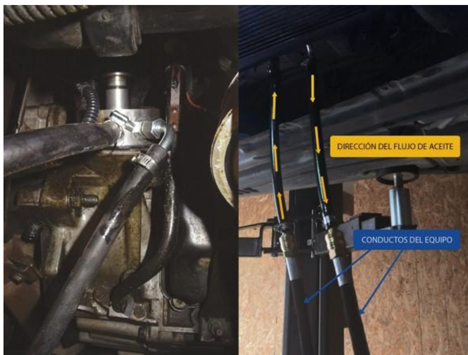
Figura 6. Conexión del equipo a la caja de cambios mediante los adaptadores. A la derecha: Conexión al conducto de aceite del circuito de refrigeración de la caja de cambios. A la izquierda: En este caso, en la caja de cambios AW55-50 se ha sustituido el intercambiador de calor circular por un adaptador especial (con junta y separadores).
