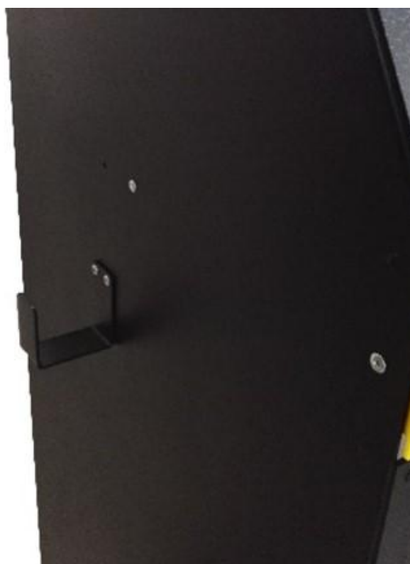
Figura 28. Punto de fijación de los ganchos mediante remaches
